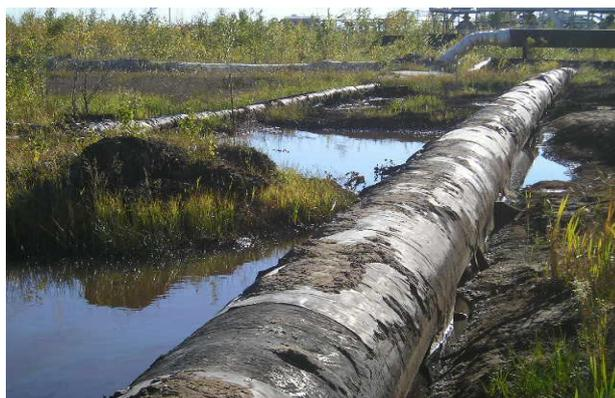
**Рис. 56. Нефтяное загрязнение при коррозии трубопровода Самотлорское месторождение**
