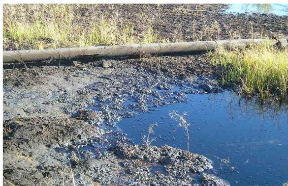
*Рис. 57. Нефтяное загрязнение при проложении нефтепровода. Вахское месторождение*
