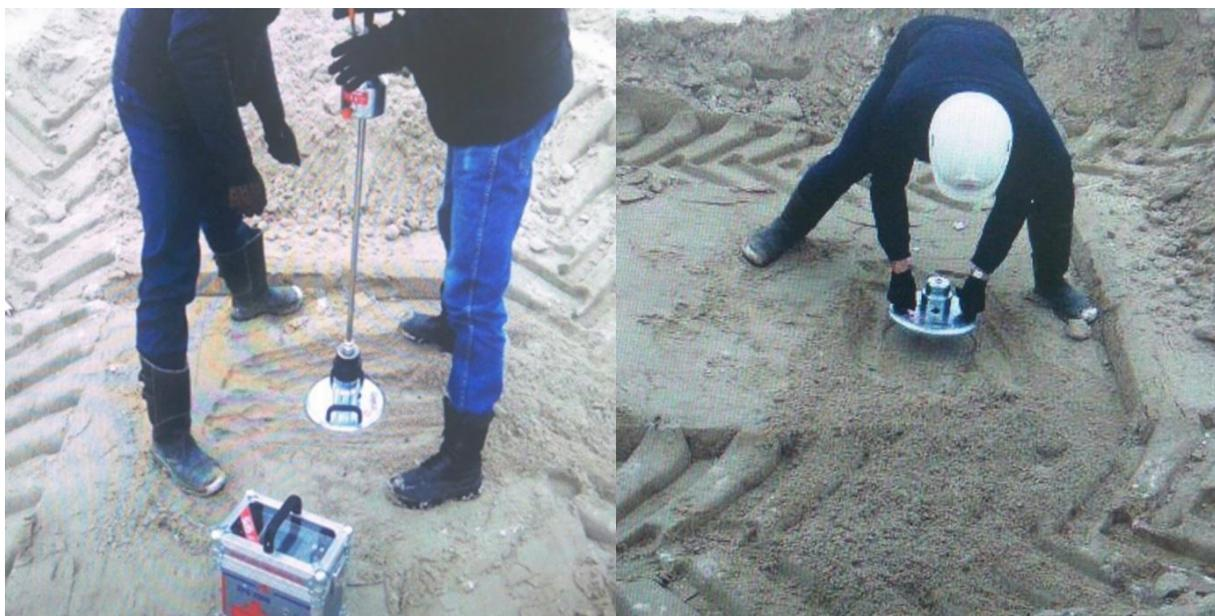
Рис. 3. Проверка качества уплотнения грунта
