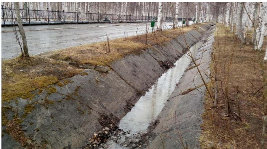
Рис. 2. Открытая система отвода поверхностных вод в Парке Победы на территории города Нижневартовска (фото Н.С. Генералова)
