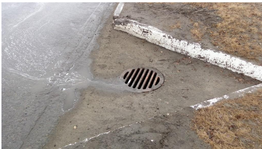
Рис. 1. Закрытая система отвода поверхностных вод в Прибрежной зоне на территории города Нижневартовска (фото Н.С. Генералова)
