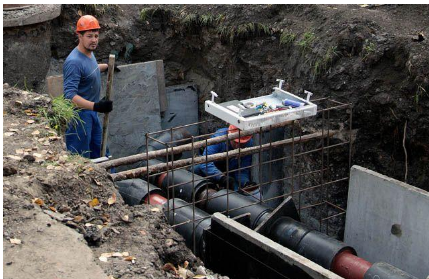
Рис. 5. Проведение гидравлических испытаний
