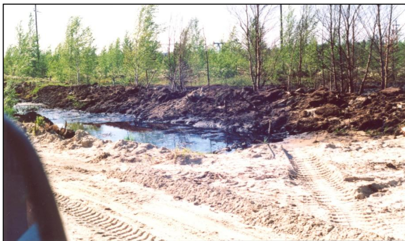
Последствия свежей аварии нефтепровода, район К – 768 (2002 г.)
