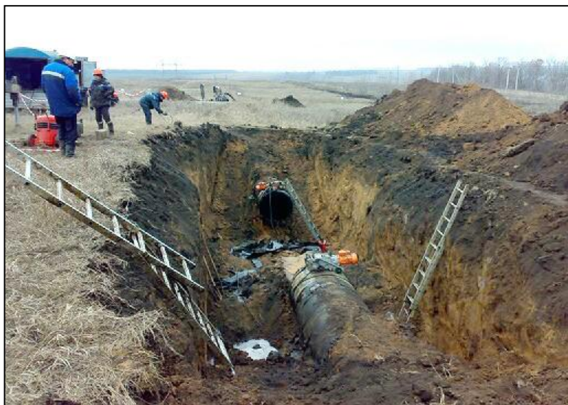
Порыв внутрипромыслового нефтепровода на территории Самотлорского месторождения, 2011 г.
