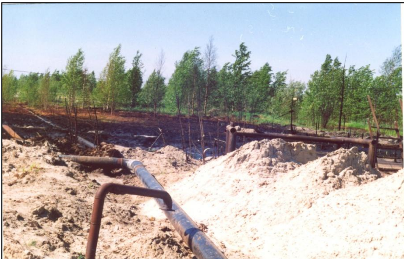
Авария напорного нефтепровода, район К – 1181 (2002 г.)
