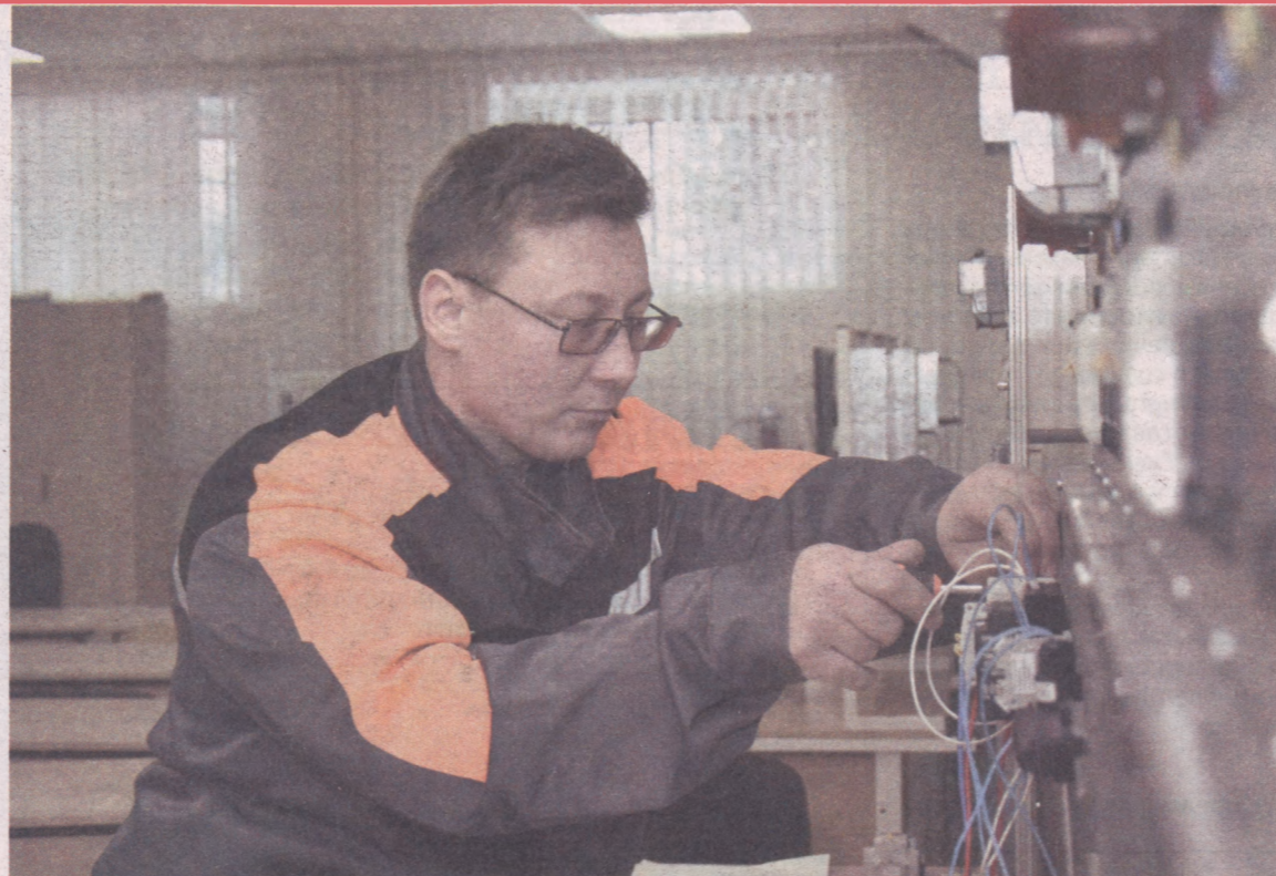
Выполняя практическое задание, слесари КИПиА монтировали схему системы измерения температуры воздуха.
