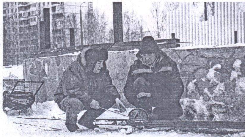
Идут завершающие работы.
