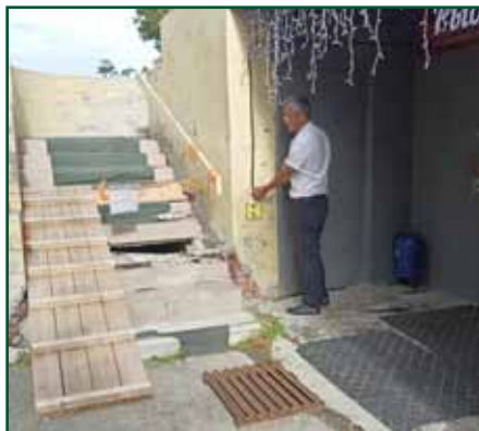
Вход в аптеку по ул. Карла Маркса, 30, г. Ханты-Мансийск (до ремонта)
