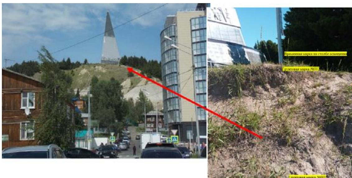
Рис. 1.3. Оползневой склон у подножия Стелы «Первооткрывателям земли Югорской» (Ханты-Мансийский участок, ХМАО-Югра, 2018 г.)
